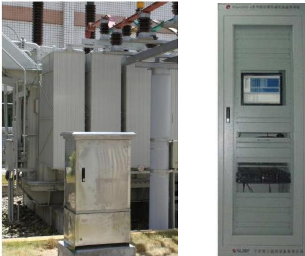
图 2.2 GS-101H 变压器油色谱在线监测系统实物照片
