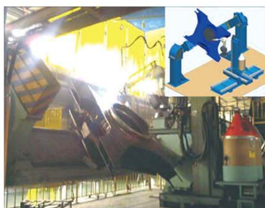
中心支架焊接机器人系统
